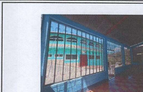
Foto 2: Sustitucion de Barandas en el corredor
