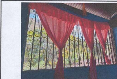
Foto 4: Sustitucion de ventanas de aluminio por pvc dañadas vidrios quebrados, tambien se sustituiran los balcones
